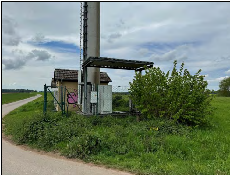
Abb.: Bewuchs am Funkmast (r.)
